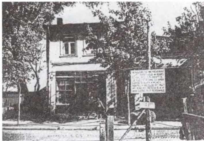
Clădirea în care a funcționat comunitatea București Nord
